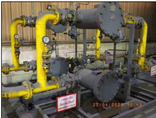
รูปที่ 2.50 วาล์วควบคุมการไหลของก๊าซ
