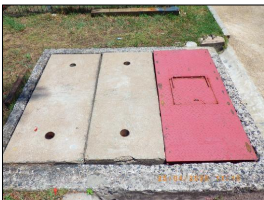
รูปที่ 2.8 บ่อตรวจสอบคุณภาพน้ำทิ้ง (Inspection Pit)
