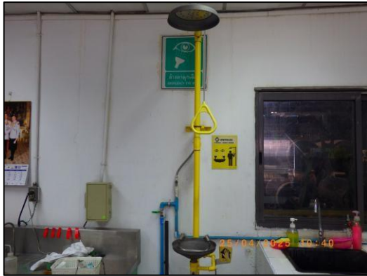
รูปที่ 2.31 ฝักบัวฉุกเฉินและอ่างล้างตา
