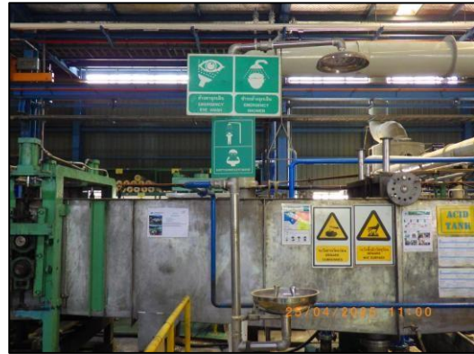
รูปที่ 2.31 ฝักบัวฉุกเฉินและอ่างล้างตา
