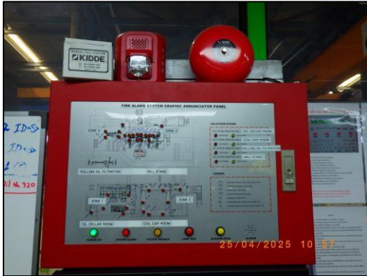
รูปที่ 2.47 แผงควบคุมระบบแจ้งเหตุเพลิงไหม้
