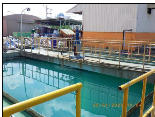
รูปที่ 2.9 ระบบบำบัดน้ำเสียทางเคมี (ต่อ)
