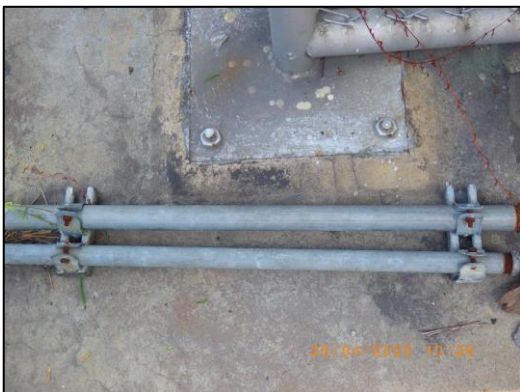
รูปที่ 2.36 การติดตั้งสายดิน
