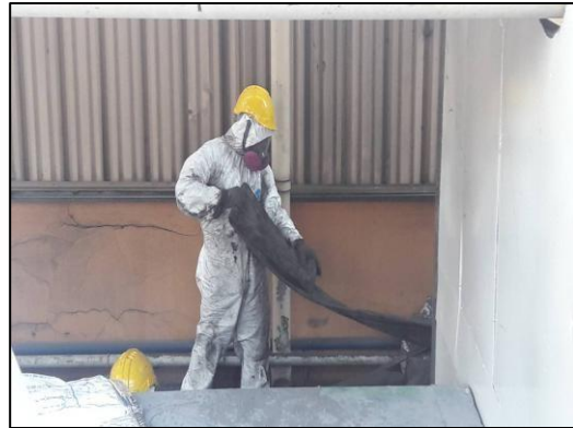
รูปที่ 2.41 พนักงานสวมใส่อุปกรณ์ป้องกัน ขณะเปลี่ยนถุงกรอง
